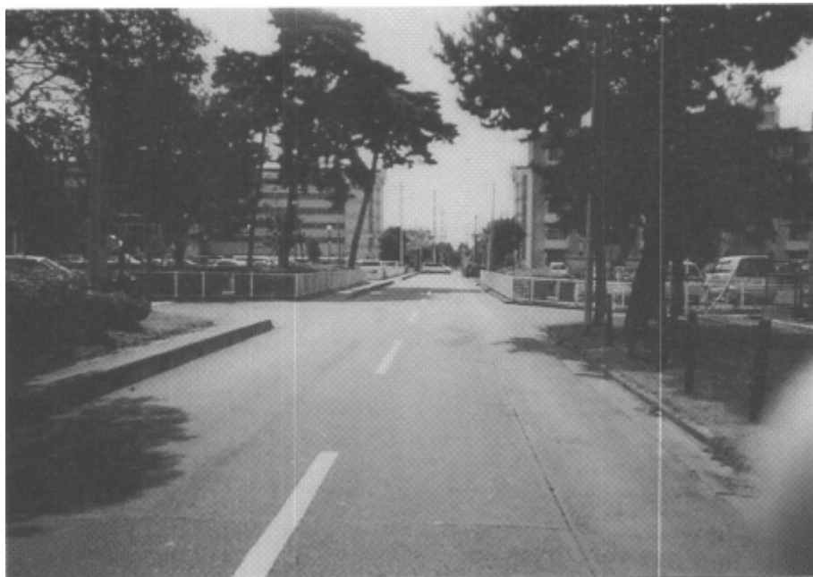
図2.4.16 区間13 (片側1車線道路)
