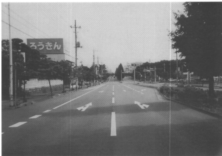
図 2.4.4 区間 1 (片側 2 車線道路)
