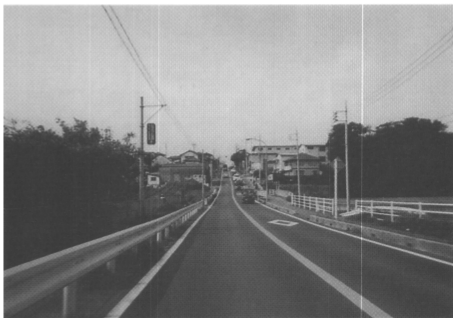
図2.4.9 区間6（片側2車線道路）
