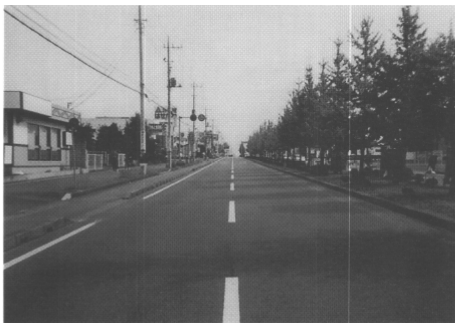
図 2.4.5 区間 2、3 (片側 2 車線道路)
