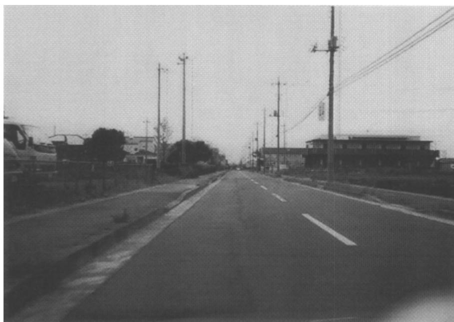
図 2.4.7 区間 5（片側 1 車線道路）
