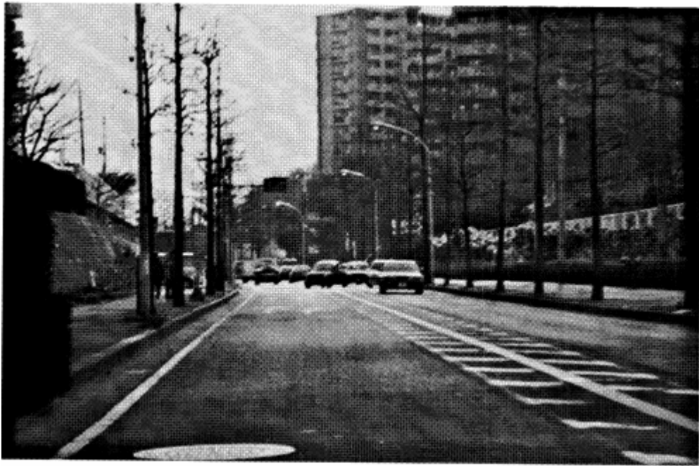
図2.3.8 右折交差点手前の直進区間（区間5）
