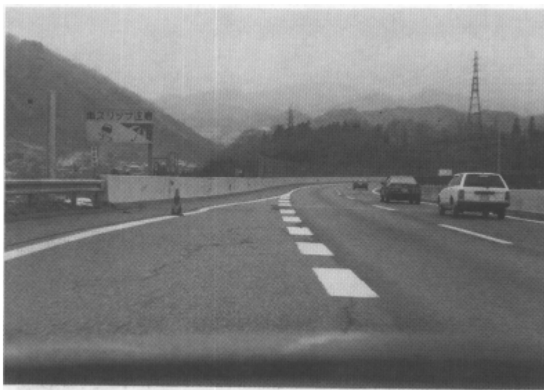
写真3-20 高速道路(3)：相模湖IC下り線流入状況
