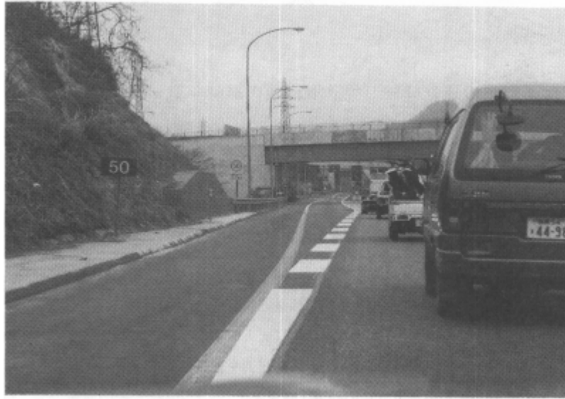
写真3-21 高速道路(4)：上野原IC下り線流出状況
