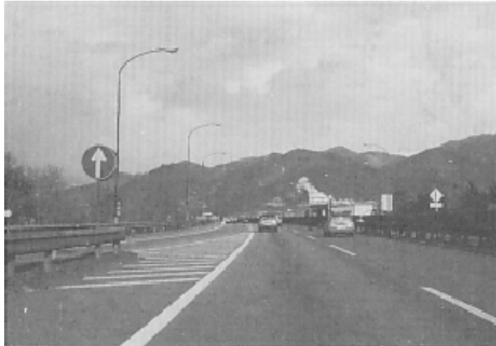
写真 3-2-3-6 インターチェンジでの合流部：高速道路(Ⅱ)
