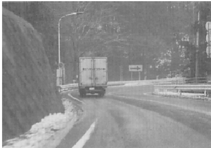
写真 3-2-2-2 対象カーブ(左 R60→右 R30)への進入(上り方向): 山岳道路 (I)
