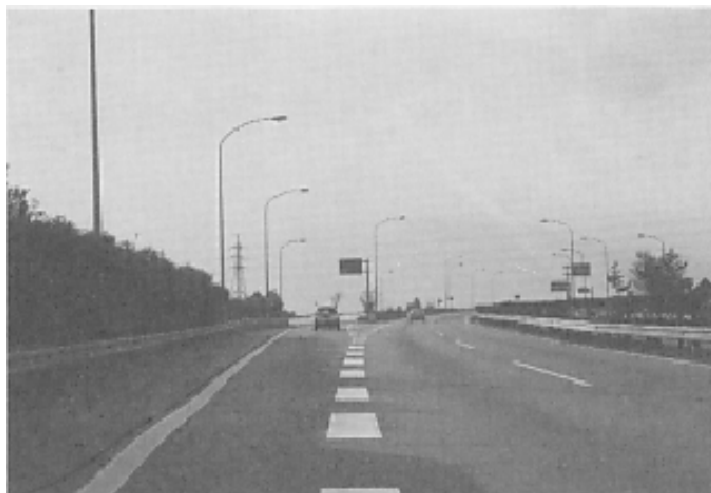
写真 3-2-3-8 インターチェンジでの流出(その2)：高速道路(Ⅱ)
