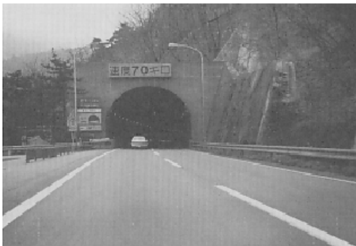
写真3-2-3-12 長大トンネル(笹子トンネル)：高速道路(Ⅱ)
