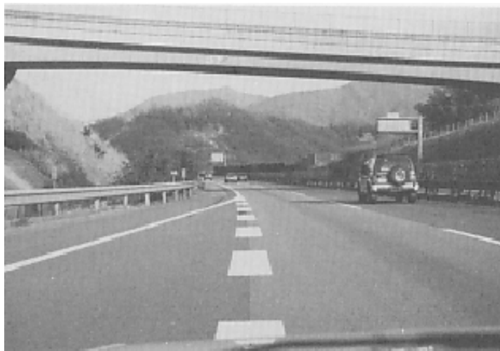
写真 3-2-3-11 インターチェンジでの流入(その 2) : 高速道路(Ⅱ)
