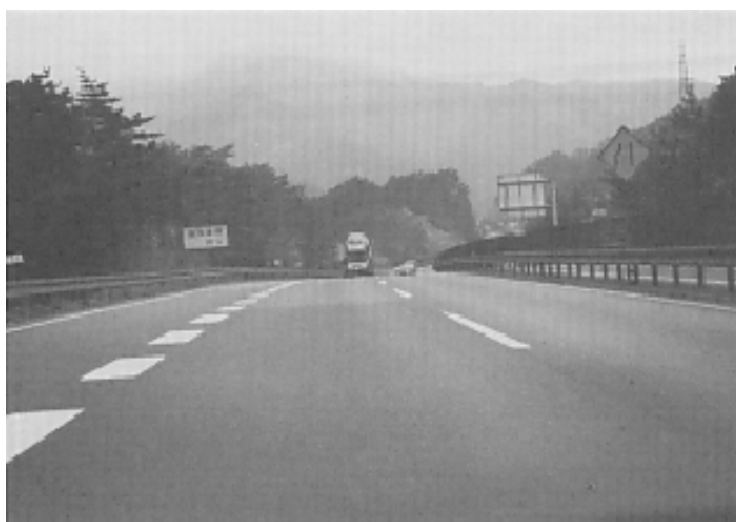
写真3-2-3-14 登坂車線終りによる合流：高速道路(Ⅱ)
