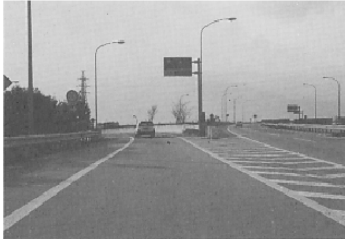
写真 3-2-3-9 インターチェンジでの流出(その 3) : 高速道路(Ⅱ)
