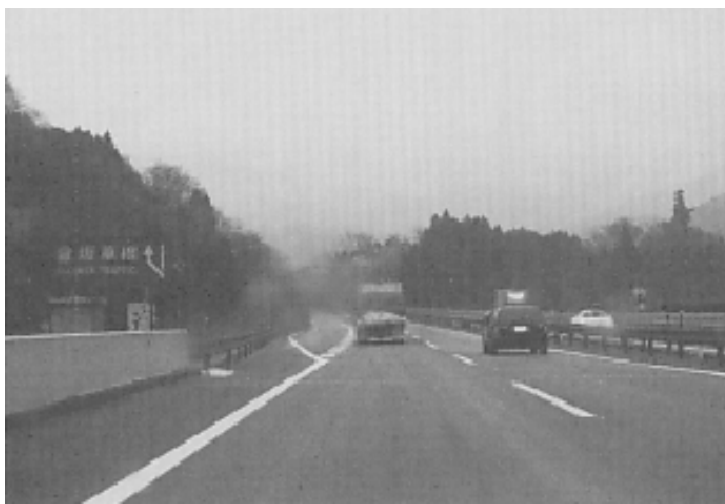
写真3-2-3-13 登坂車線始まりによる分流：高速道路(Ⅱ)
