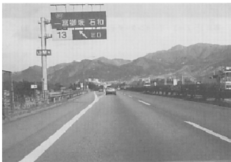
写真3-2-3-5 インターチェンジでの分流部：高速道路（Ⅱ）
