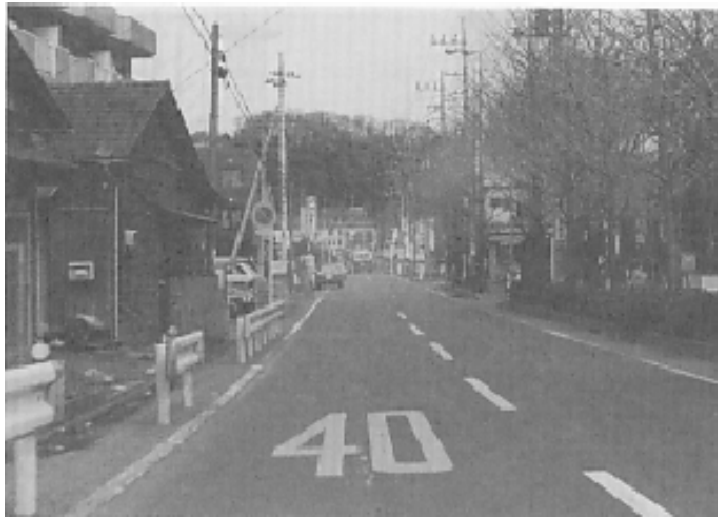
写真 3-2-1-9 ㊦～㊧区間の直線区間(後半)：市街路(Ⅰ)
