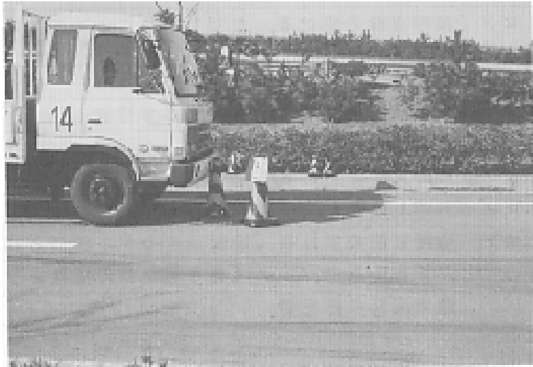
写真5-15 車両の陰へのパネル設置状況
