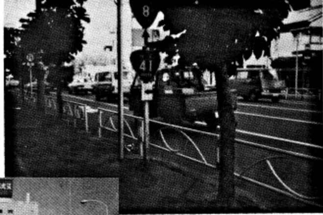
写真4-8 ガードパイプが設置されている 交差点
