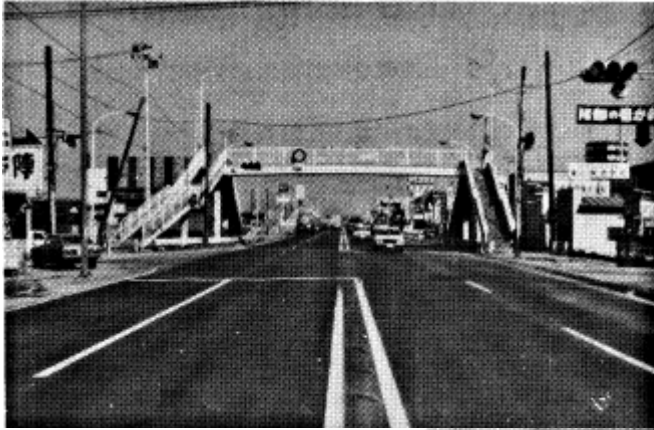
写真4-12 横断歩道が設置されている交差点
