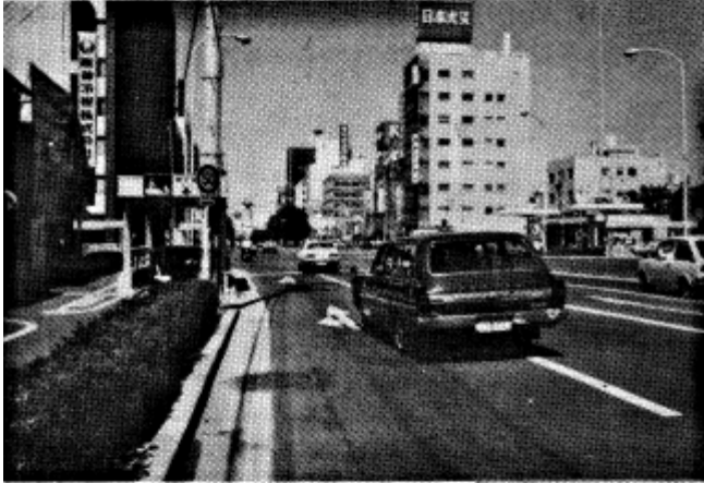
写真4-9 緑地帯の防護柵が設置されてい る交差点
