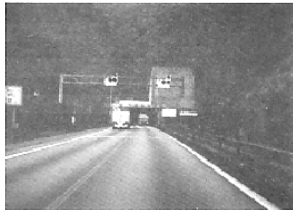
トンネル手前の信号装置
